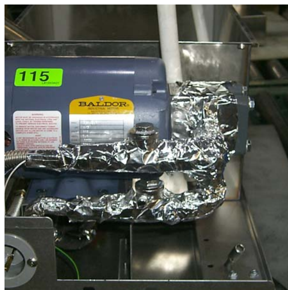
Gotowa instalacja paska grzewczego [115V PF50 (Powrót/Ssanie)].
